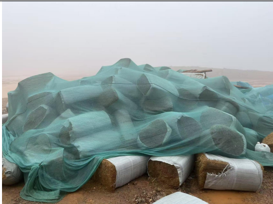
边坡草籽防护
