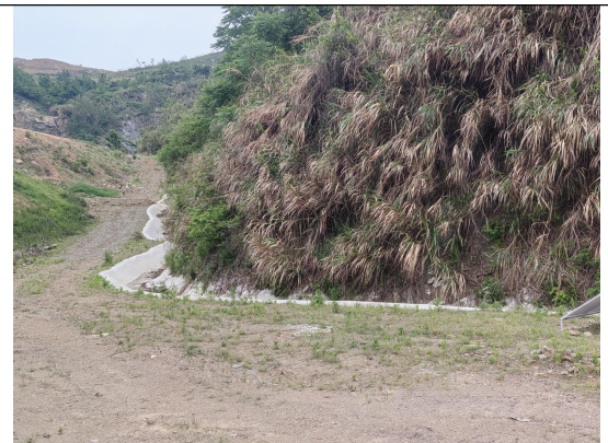
临时堆场硬化排水沟
