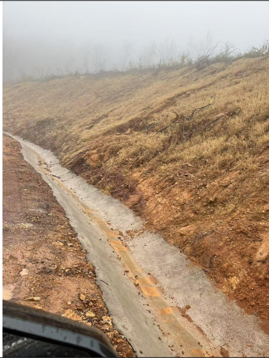
采场硬化排水沟
