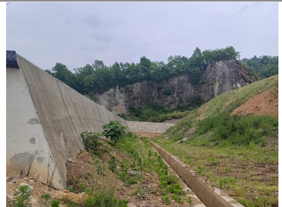
临时堆场拦渣坝
